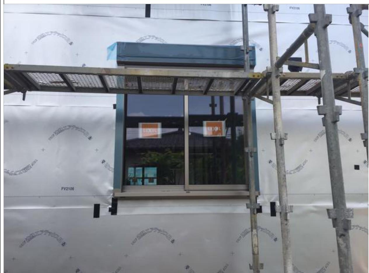
3-5□透湿防水シート（防水紙）の重ね代は、左右150mm、上下90mm以上取る。ステープルのピッチは100mmを目安とする。出入隅部は重ねつくりの施工をし、その際重ね代を150mm以上確保し、かつ重ね部分を乱にする。
