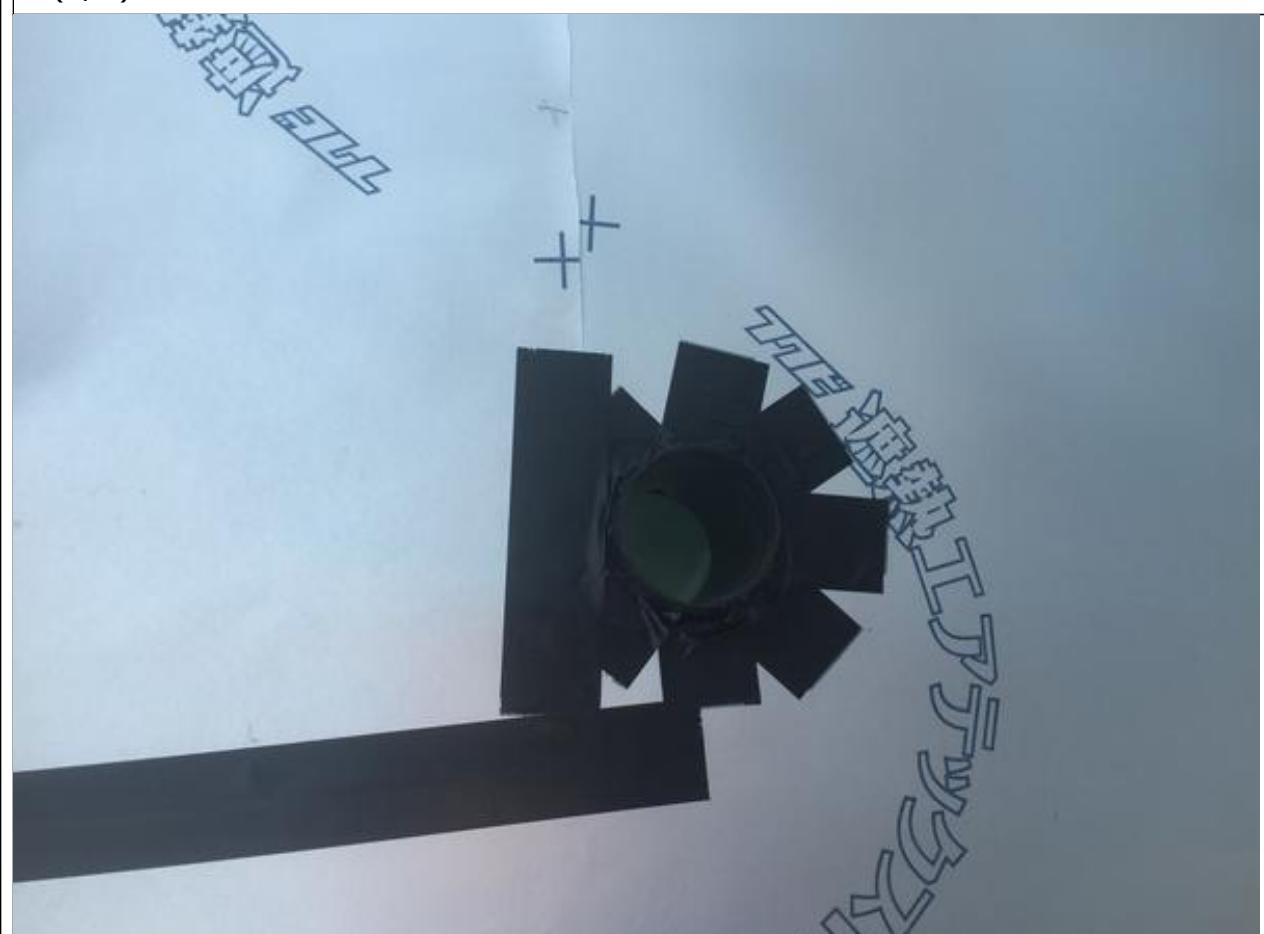
3-11 配管、配線が2本以上貫通する場合は、さや管を使用し、防水措置を適切に処理する。
