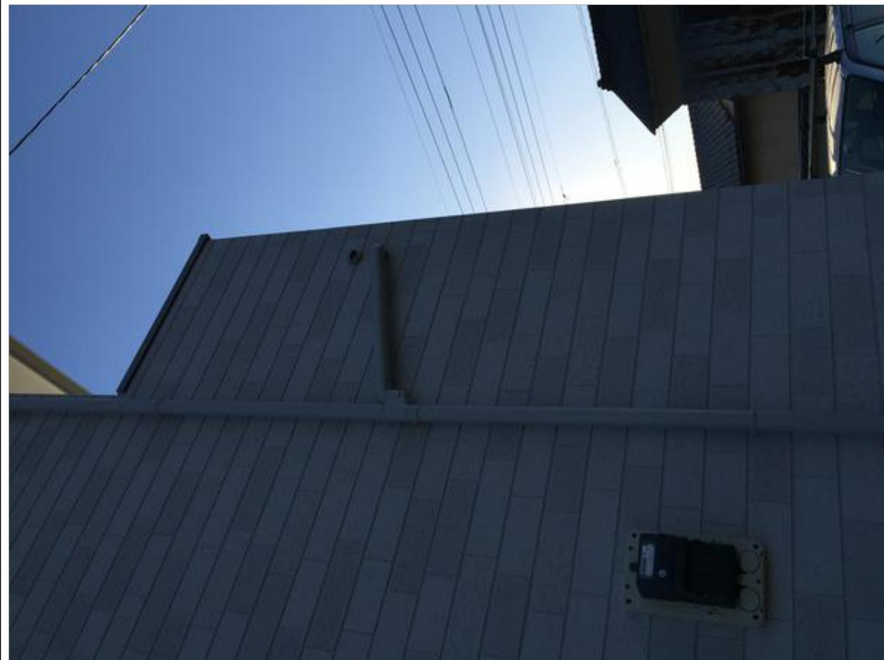
3-15 窯業系サイディング張りの取り付けは、目地通り良く、不陸、目違い等のないように行う。サイディングと土台水切り等の取り合いは、10mm程度の隙間をあける。
