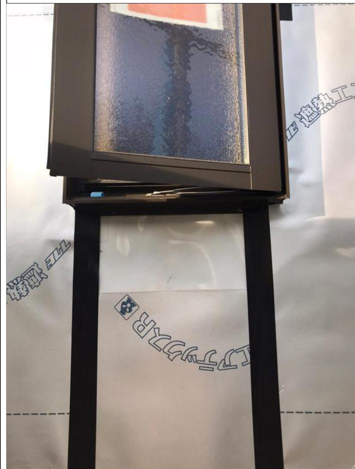
3-2□両面防水テープを用いて、サッシくぎ打ちフィンの根元を十分に覆い、縦・横の防水テープ交差部にすき間が生じないように張る。
